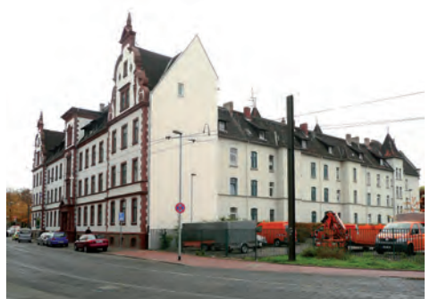
Wagenersche Stiftung: Wohngebäudekomplex Autor: AxelHH
